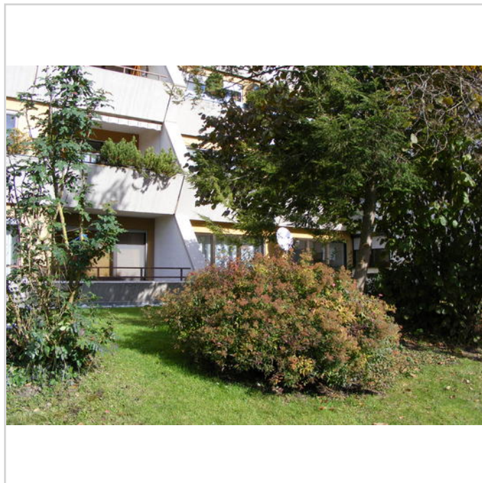
Blick von außen
